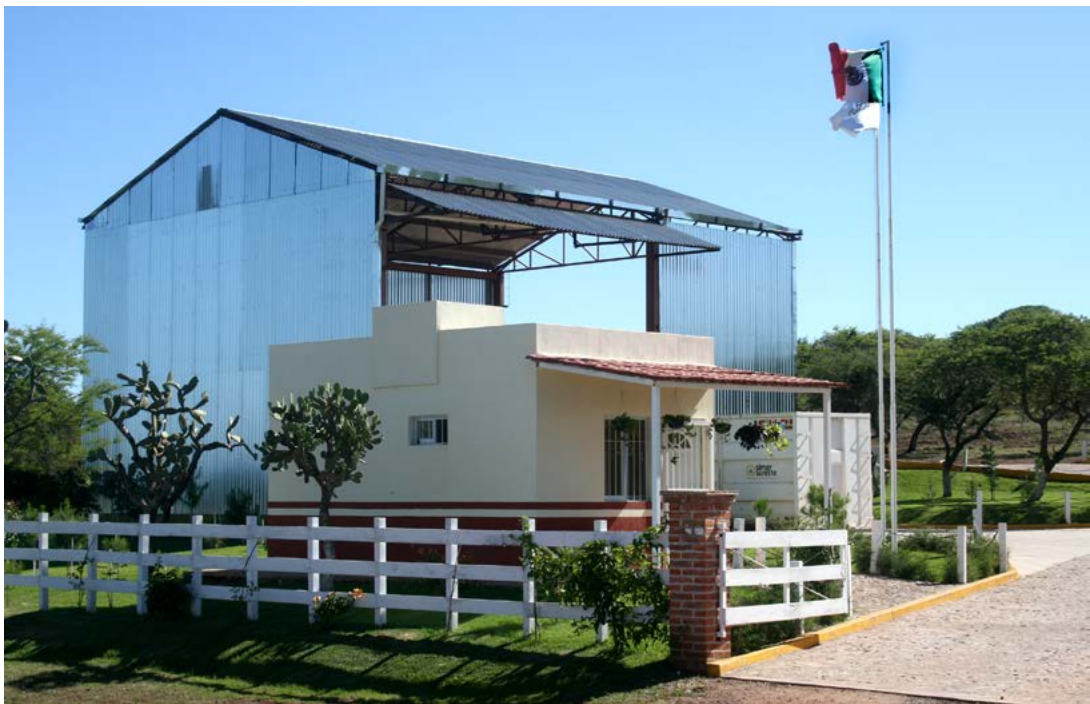
Estación de Transferencia Intermunicipal de Residuos
