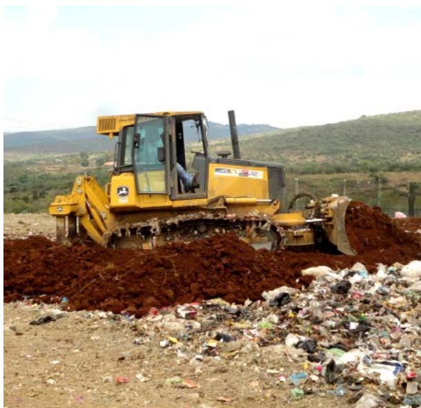
Operación de compactación y cobertura de residuos sólidos en el relleno sanitario
