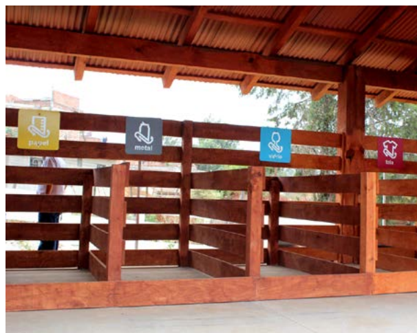
Punto verde para el acopio de residuos en el municipio de Quitupan
