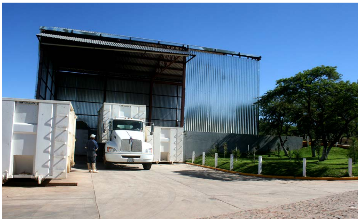
Estación Intermunicipal de Transferencia de Residuos Suroeste
