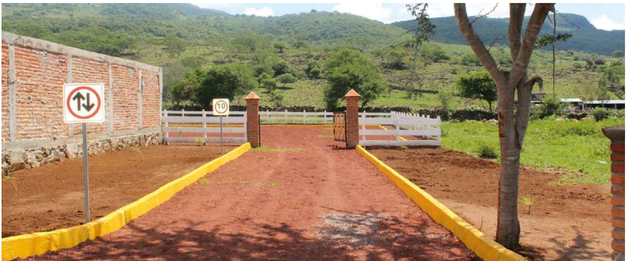
Centro de acopio de residuos valorizables de Quitupan. Septiembre, 2013.
