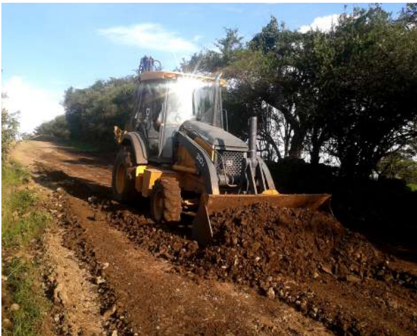
Trabajos de mantenimiento de brecha camino al relleno sanitario SIMAR Sureste, 2014.
