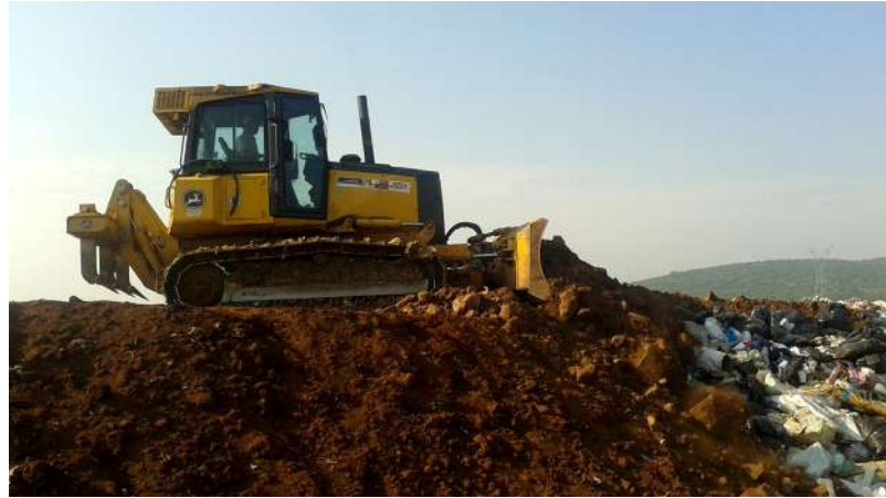
Cobertura de residuos sólidos en el relleno sanitario SIMAR Sureste, 2014.
