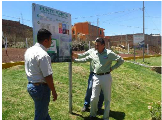
Construcción de puntos de acopio de residuos valorizables en San José de Gracia, Michoacán, marzo del 2014.
