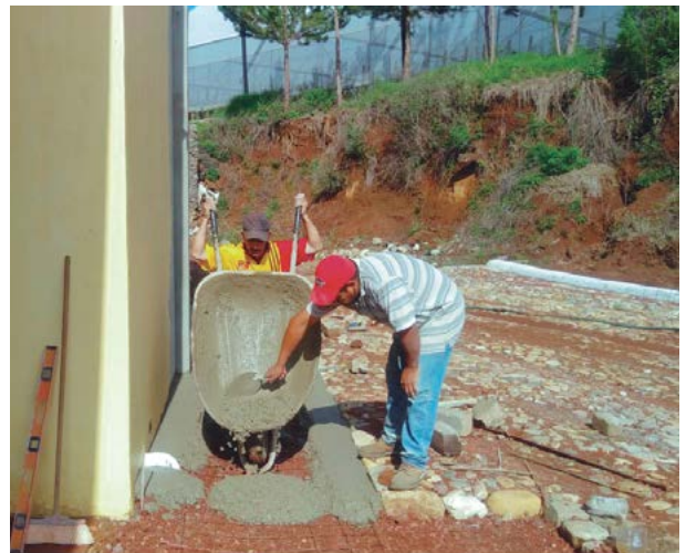
Obras de reparación de muros con hundimiento y filtraciones en techos que presentaban daños por humedad, así como construcción de banqueta y empedrado de 640 metros en el Centro Intermunicipal de Educación Cívico Ambiental. 2017.
