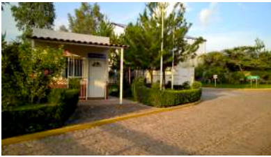
Ingreso Estación de Transferencia Intermunicipal de Residuos Sólidos SIMAR Sureste, que recibe los residuos de los municipios de Tecuitatlan, La Manzanilla de la Paz, Concepción de Buenos Aires y Tuxcueca.
