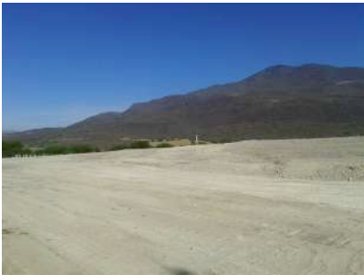
Vista del saneamiento del relleno sanitario de Teocuitatlán de Corona, con recursos federales gestionados por SIMAR Sureste, 2015.
