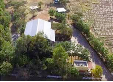
Estación de Transferencia intermunicipal de residuos sólidos SIMAR Sureste.
