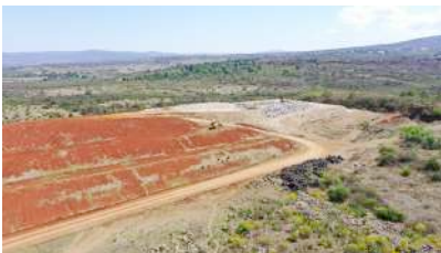
Vista aérea del relleno sanitario SIMAR Sureste, 2018.
