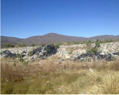
Vista de la mala operación del relleno sanitario del municipio de Teocuitatlán de Corona, 2014.
