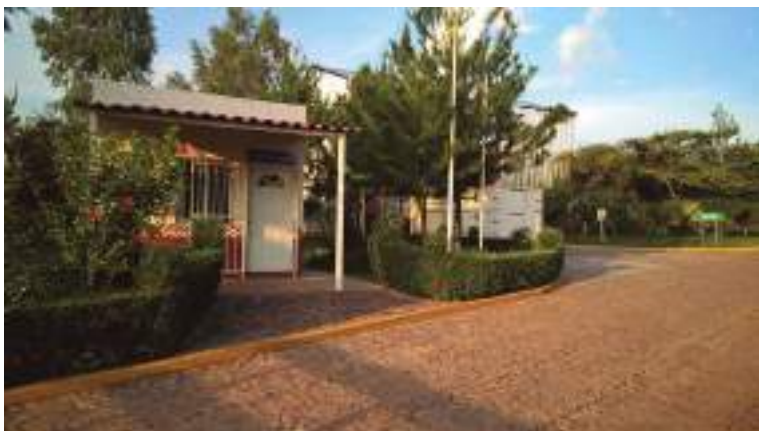
IMAGEN 51. Estación Intermunicipal de Transferencia de Residuos Sólidos Sureste
