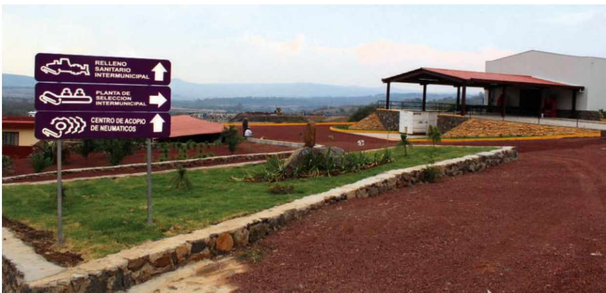
Vista de planta de selección de residuos suroeste. Junio, 2012.
